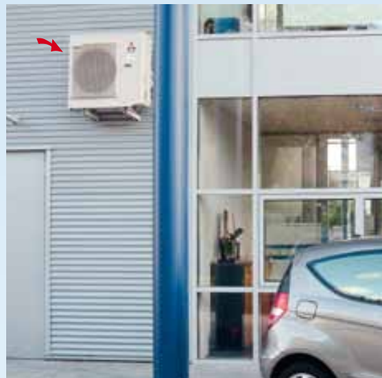
BERESA, Ahaus: Klimatisierung von 3 Büroräumen über jeweils eine 4-Wege-Kassette im Euro-raster-Maß (62,5 x 62,5 cm) an nur einem Außengerät (Multi-Split).
